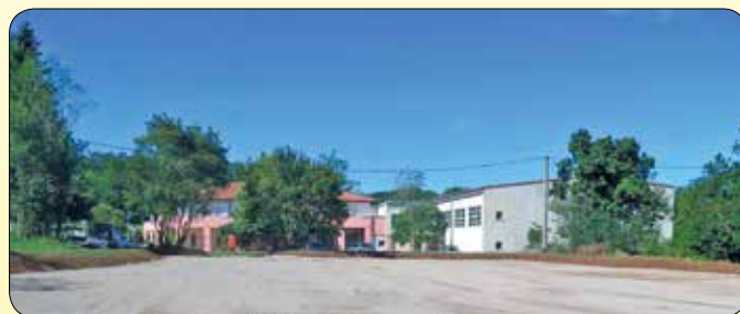
Novo makadamsko parkirišče pred komensko šolo
