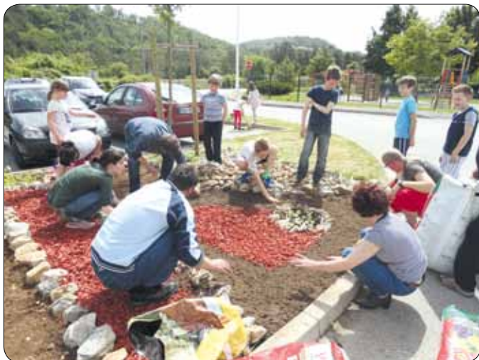
Urejanje skalnjaka pred šolo
