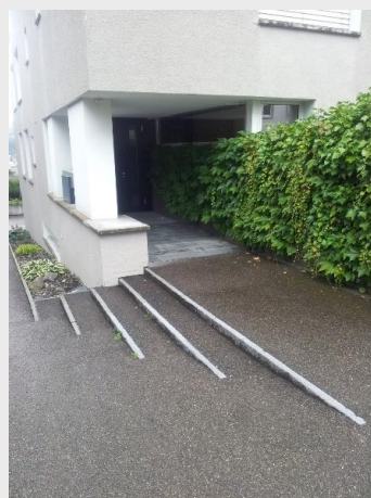
Sliki 4: Vizualna zaznava roba na stopnicah 1 (neustrezno): Stopnice z nekontrastnimi robovi. Med stopnicami je umeščena tudi klančina, ki še dodatno oteži zaznavanje robov stopnic. 2 (ustrezno): Označitev terenskih stopnic z vizualnim kontrastom na robovih.
