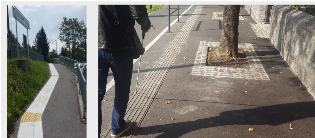
Sliki 12: Talni taktilni vodilni sistem niso samo taktilne oznake 1 (neustrezno): Taktilna vodilna linija je postavljena ob robu. Ta je že sam zelo dobro zaznaven, zato linija v takšnem primeru ni potrebna. Stroški izvedbe in vzdrževanja pločnika so tako po nepotrebem zelo visoki, taktilna linija pa tudi zelo močno vpliva na podobo prostora. 2 (ustrezno): Primer, ko je standardno taktilno vodilno oznako nujno načrtovati zato, da se pešec z okvaro vida lahko izogne oviram, ki so ob robu in jih ni mogoče umakniti.
