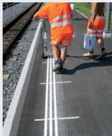
Sliki 9: Vodilne reliefne črte iz hladne strukturne plastike. 1 (neustrezno): Izvedba, ki je glede na standard previsoka in zato povzroča hrup. 2 (ustrezno): Označitev s posameznimi črtami, nanešenimi neposredno na asfalt.
