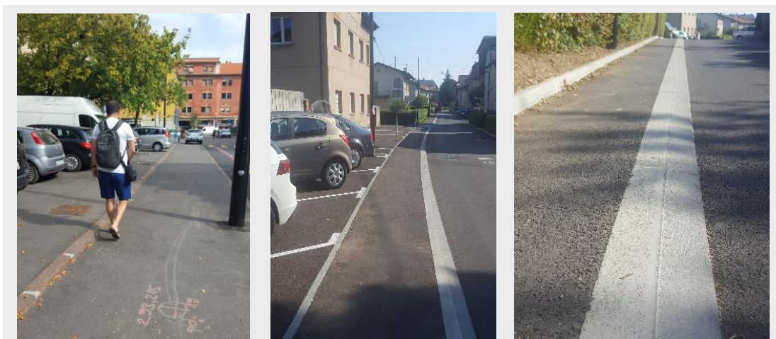
Slike 3 (ustrezno): Ustrezna rešitev v primeru, ko je ob pločniku načrtovano parkirišče. 1: meja med parkiriščem in pločnikom je nakazana kot robnik, visok 3 cm, ki mu slepi lahko sledijo s palico. 2 in 3: Primer ležečega robnika v primeru manj prometnih cest, ob katerih je veliko uvozov in parkirišč ob pločniku. Meja med voziščem in pločnikom je poševni robnik, ki je tipno zaznaven, obenem pa omogoča avtomobilom, da zapeljejo na dovoz.
