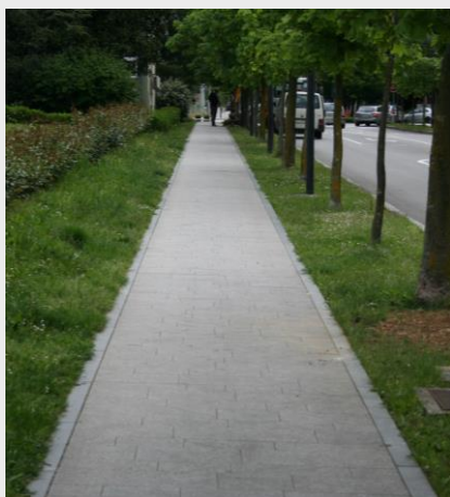
Sliki 1: Primera robov pločnika. 1 (ustrezno): Nečlenjen rob 2 (neustrezno): Zelo členjen rob, ki je manj primeren za orientacijo uporabnikov bele palice.
