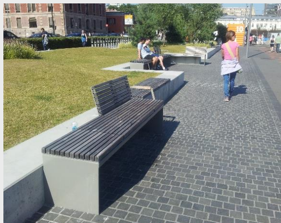
Sliki 1: Primera robov pločnika. 1 (ustrezno): Nečlenjen rob 2 (neustrezno): Zelo členjen rob, ki je manj primeren za orientacijo uporabnikov bele palice.
