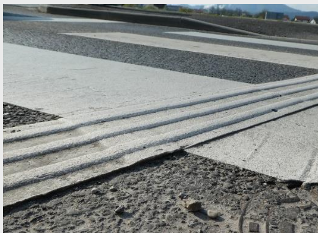
Sliki 9: Vodilne reliefne črte iz hladne strukturne plastike. 1 (neustrezno): Izvedba, ki je glede na standard previsoka in zato povzroča hrup. 2 (ustrezno): Označitev s posameznimi črtami, nanešenimi neposredno na asfalt.
