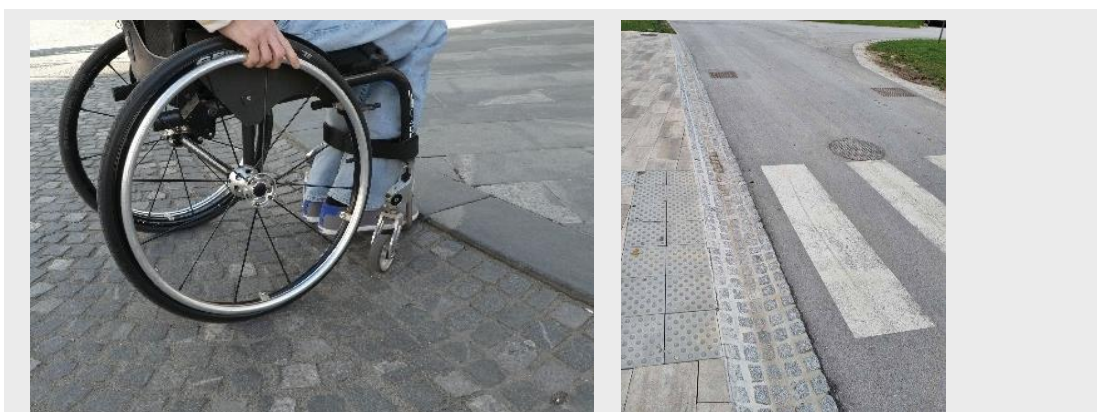
Sliki 2 (neustrezno): Ovire za uporabnike invalidskih vozičkov na pločnikih. Pri načrtovanju je treba določiti glavne smeri gibanja pešcev. 1: Prehod čez muldo in robnik ovira prehod z invalidskim vozičkom. Če je predvideno, da se pešci gibljejo vzdolž robnika (npr. v območjih za pešce), je lahko takšen robnik ustrezen ukrep za olajšanje orientacije slepih in slabovidnih, vendar morajo biti ustrezno urejena mesta prehoda. 2: Tam, kjer je predvideno prečno gibanje pešcev čez muldo, takšna postavitev predstavlja oviro za prehod uporabnikov invalidskih vozičkov in je neustrezna.
