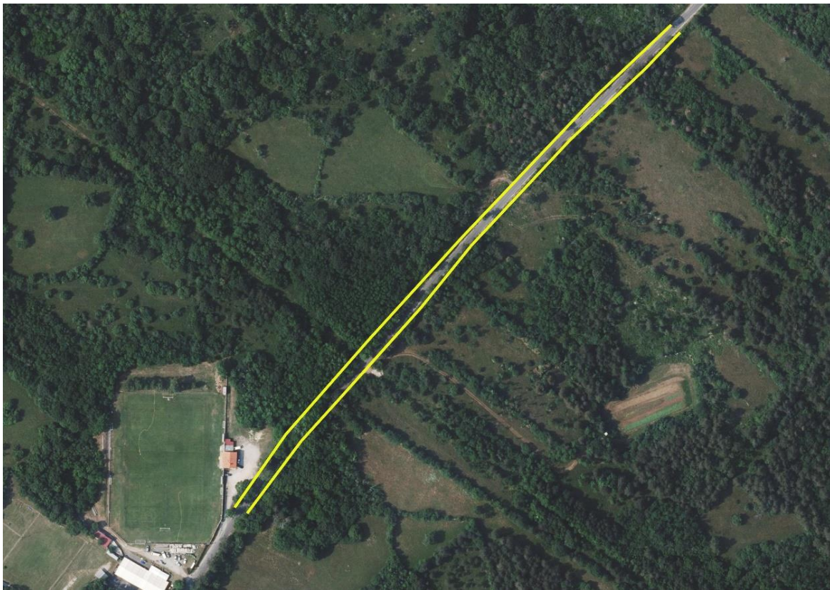
Slika 2: Območje postavitve varovalne ograje na regionalni cesti Branik–Komen.
