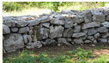
Prosto stoječi suhi zid je narejen iz skoraj neobdelanih kamnov, nabranih na zemljišču v neposredni okolici gradnje. Prav različne velikosti in oblike kamnov, ki jih je potrebno skrbno in po temeljitem premisleku zlagati tako, da iz njih dobimo homogeno celoto, so odraz mojstrskih znanj naših prednikov, kar daje tako grajenemu zidu dodano vrednost. Zidovi, zidani iz klesanih kamnov z ravnimi robovi, v takšno tradicijo zagotovo ne sodijo.
