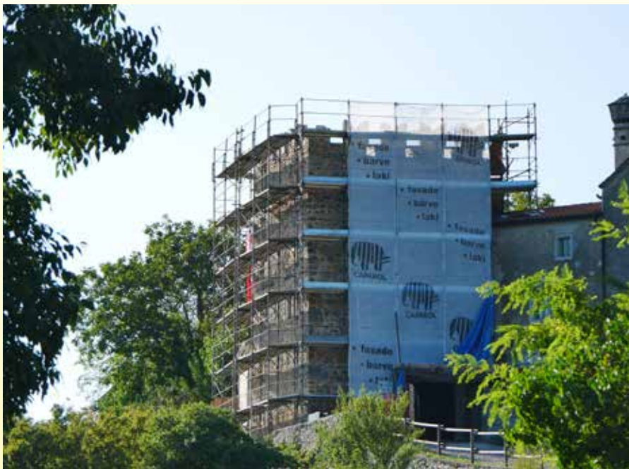
Obnova Kobdiljskega stolpa.
