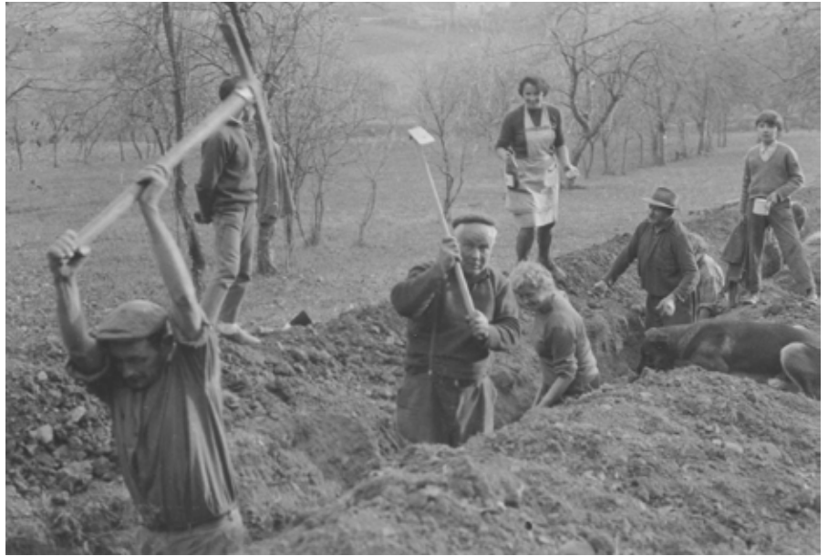
V 50. letih prejšnjega stoletja so Kobolovci prekopal kmetijska zemljišča, da so zamenjali dotrajane cevi od zajetja do studenca (Foto: osebni arhiv Tilna Božiča).
