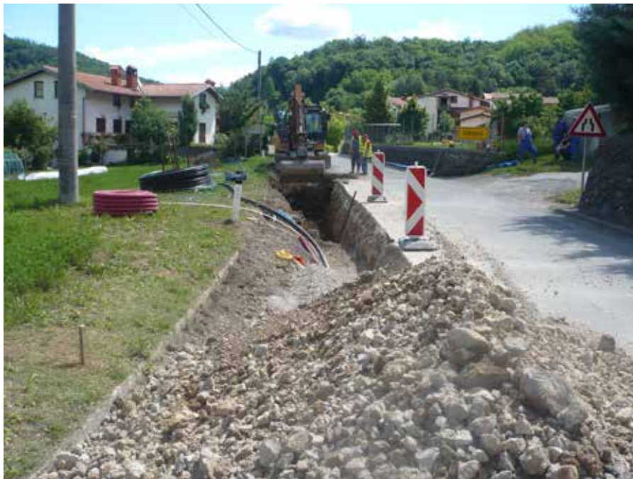
Rekonstrukcija vodovoda v Gornji Branici.
