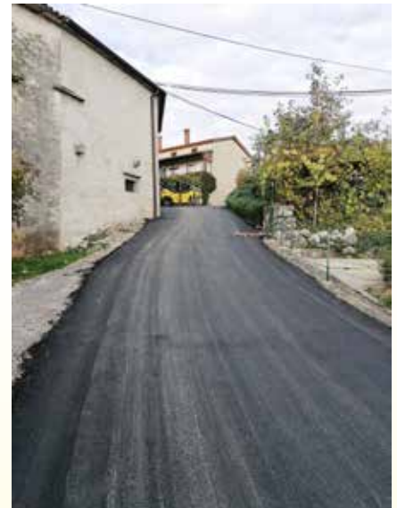
Asfaltiranje makadamske ceste pri lokvi v Kobjegla-vi v dolžini 65 m. Cesta omogoča dodatno povezavo v vas. Vrednost projekta 6.000 EUR
