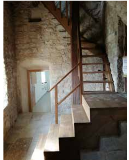
Obnovljeno stopnišče Kobdiljskega stolpa.
